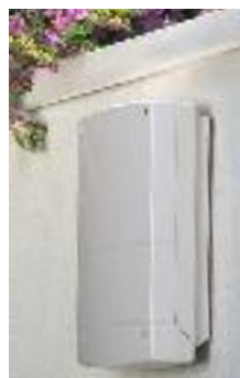
Coffret technique sans antenne visible
